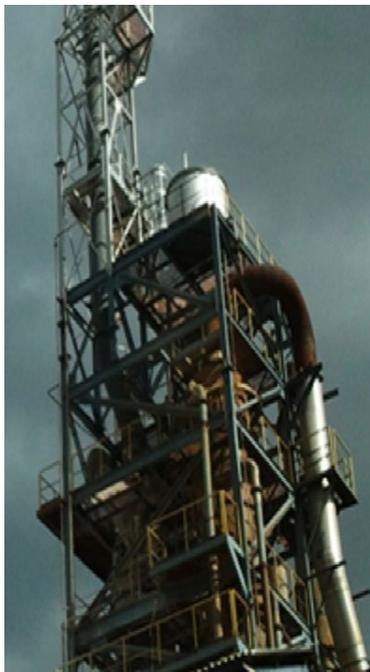
Captage de CO<sub>2</sub> pour la production de **carbonate de baryum**
